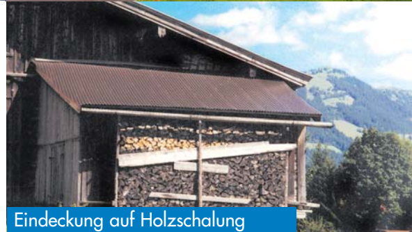
Eindeckung auf Holzschalung
